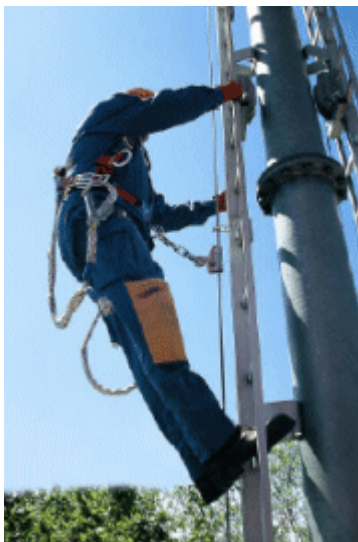
Bild 16: Beispiel einer Steigschutzeinrichtung mit Führung aus Stahldrahtseil
